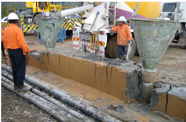
Plate 7 – Panel 25 Concrete Pour
