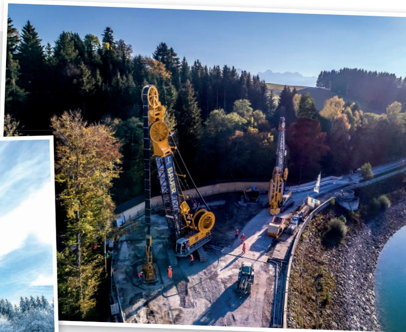
Die Dichtwandarbeiten von Bauer wurden an sieben Tagen pro Woche und in Tag- und Nachtschicht – also im 24-Stunden-Betrieb – ausgeführt. Auch während der Wintermonate.
