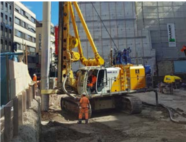
Neubau Bürogebäude, München, Deutschland Ausführung einer überschnittenen Bohrpfahlwand mit einem Durchmesser von 620 mm und 18 m Tiefe mittels VdW-Verfahren.
