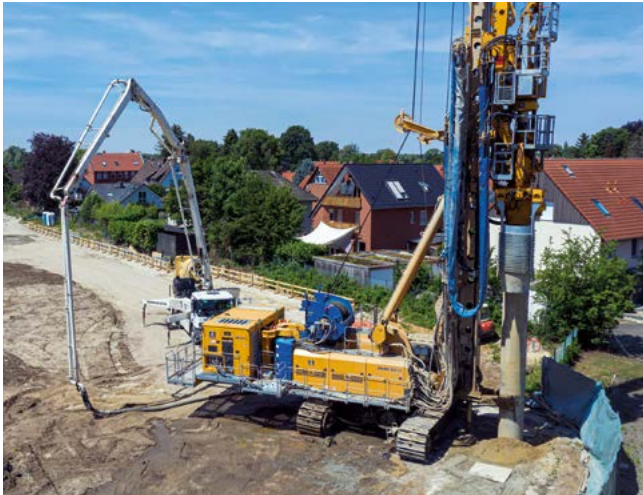
Businesspark, Hannover, Deutschland Herstellung einer überschnittenen Bohrpfahlwand mit einem Durchmesser von 880 mm und 16 m Tiefe mittels DKS-Verfahren.
