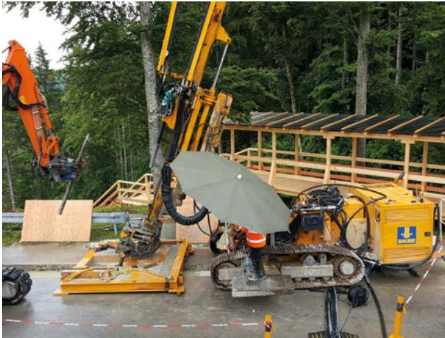
Staudamm, Roßhaupten, Deutschland Erstellung eines Felsinjektionsschleiers bis in eine Tiefe von maximal 91 m.
