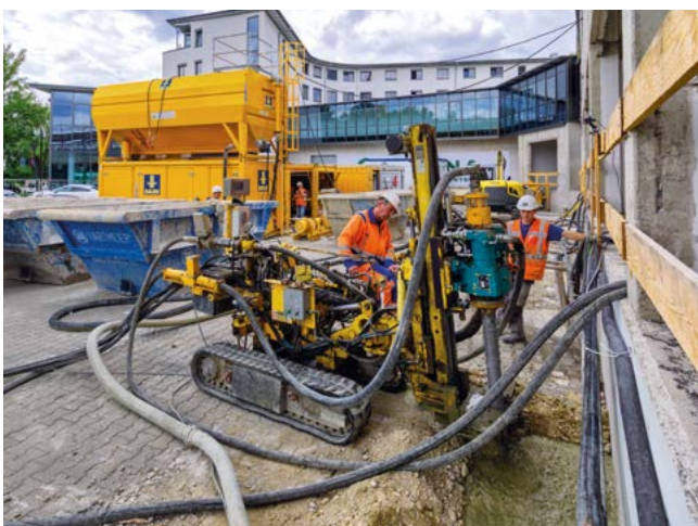
Nachgründung Industriegebäude, München, Deutschland Für die Aufstockung wurden 130 Säulen bis in eine Tiefe von ca. 8 m mittels Hochdruckinjektion ausgeführt.
