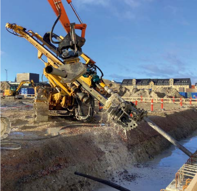
Operaparken, Kopenhagen, Dänemark Rückverankerung einer Schlitzwand in zwei Ankerlagen mit insgesamt 186 Litzenkurzzeitankern.
