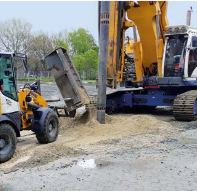
Zentrum für Tiefseeforschung (ZfT), Bremen, Deutschland Für den Neubau des ZfT in Bremen führte Bauer 5.500 m Rütteldruckverdichtung aus.
