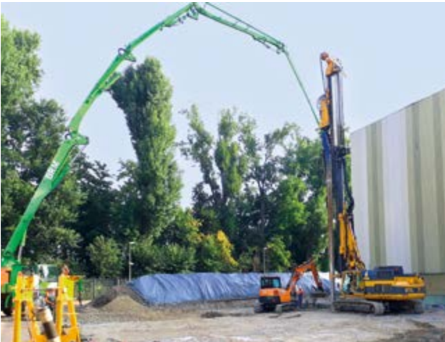
Logistikzentrum, Karlsruhe, Deutschland Für die Gründungsarbeiten eines Logistikzentrums führte Bauer 2.700 m Rüttelortbetonsäulen aus.
