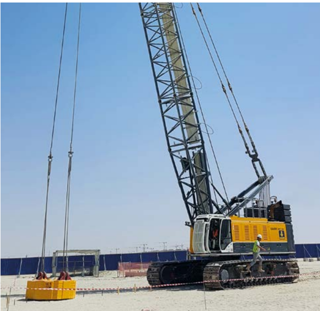
Dubai Creek Harbour, Dubai, VAE Verbesserung des Baugrundes auf ca. 500.000 m 2 mittels Rütteldruck- und dynamischer Intensivverdichtung.
