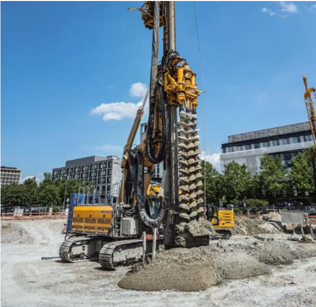
Parkstadt Schwabing, München, Deutschland Herstellung einer 6.000 m 2 einfach rückverankerten Mixed-in-Place-Dichtwand für eine 9 m tiefe Baugrube.
