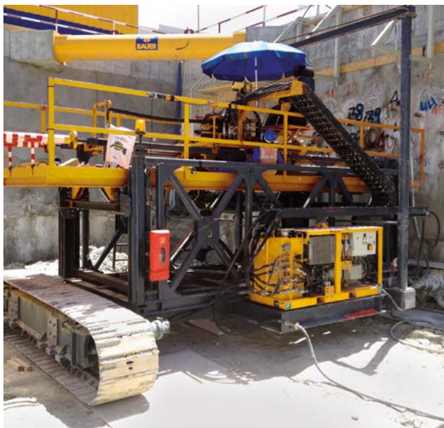
Fußgängertunnel, Doha, Katar Gesteuerte Bohrungen für die Abdichtungs- und Stabilisierungsinjektion eines Fußgängertunnels von 90 m.
