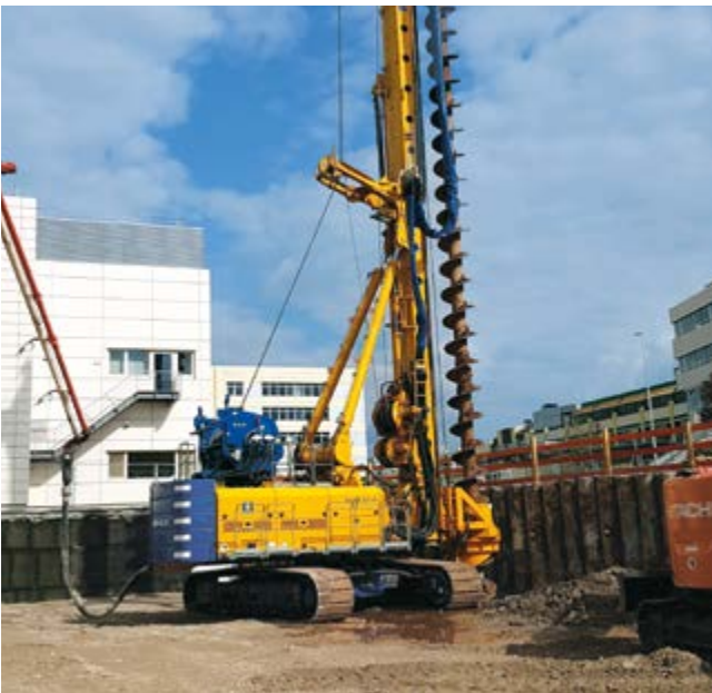
Neubau Zentrallabor, Herzogenaurach, Deutschland Bohren von Gründungspfählen mit einem Durchmesser von 1.000 mm und 18 m Tiefe mittels SOB-Verfahren.
