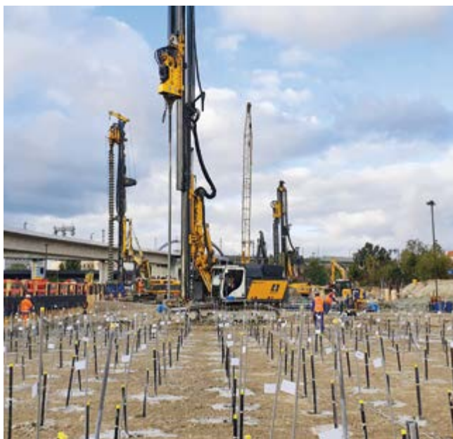
Quartier Heidestraße, Berlin, Deutschland Ausführung von 16.000 m 2 LWS-Silikatgelsohle mittels Poreninjektion.
