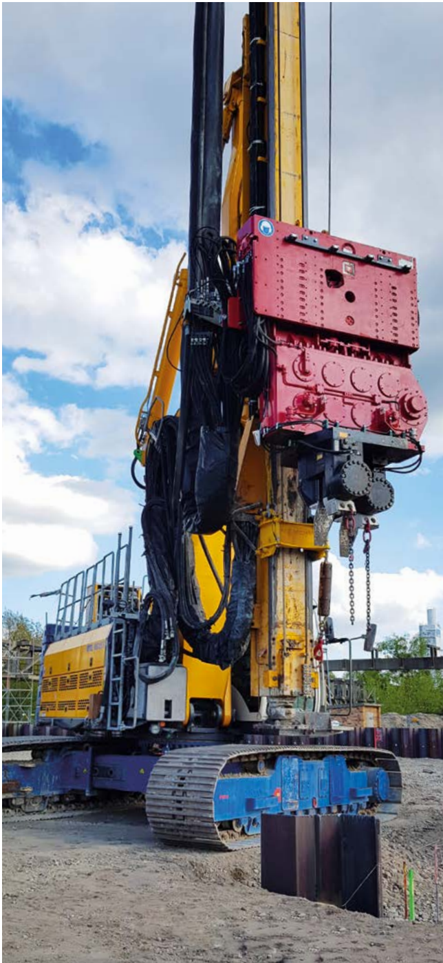
Schwarze Pumpe, Leuna, Deutschland Zur Sanierung des ehemaligen Gaswerks im Industriepark „Schwarze Pumpe“ wurden Spundwandkästen unterschiedlicher Größe, Tiefe und mit Bohlenlängen von bis zu 20 m hergestellt.
