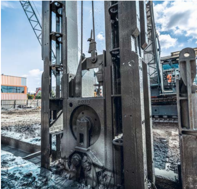
Messeingang Süd, Frankfurt am Main, Deutschland Ausführung einer 2-Phasen-Schlitzwand unter Einsatz eines MC 64 Seilbaggers mit Greifer.
