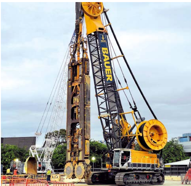
Hobson Bay, Melbourne, Australien Herstellung von zwei Schächten unter Einsatz eines MC 96 Seilbaggers mit einer BC 48 Schlitzwandfräse.
