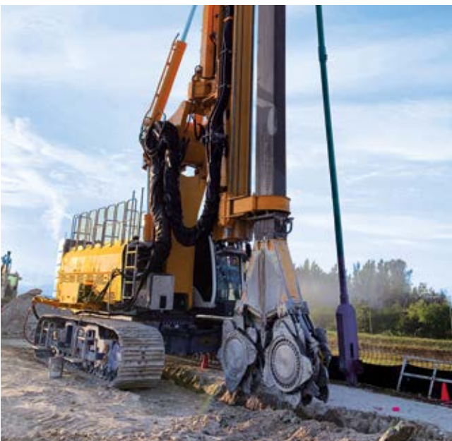
Herbert Hoover Dike, Florida, USA Zur Verbesserung der Dammsicherheit wurden 28,3 km Dichtwand mit einer Tiefe bis zu 20 m installiert.
