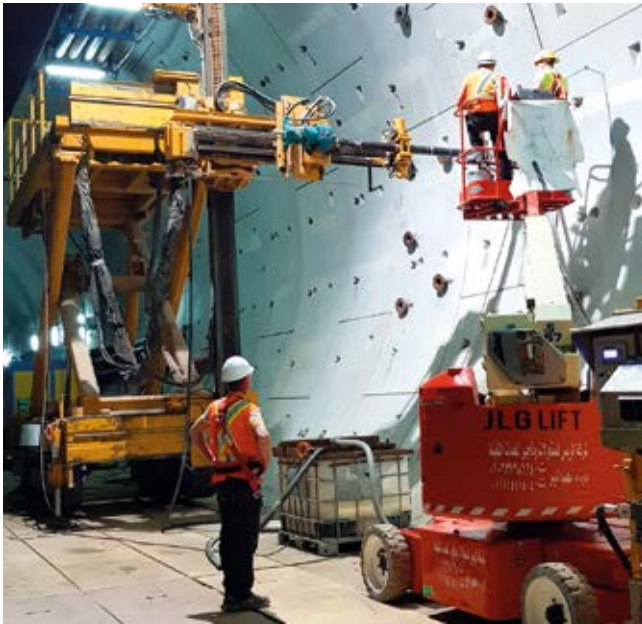
Tunnel unter Suezkanal, Ismailia, Ägypten Ausführung von vier Querstollen zur Verbindung von zwei Straßentunneln durch Solevereisung.
