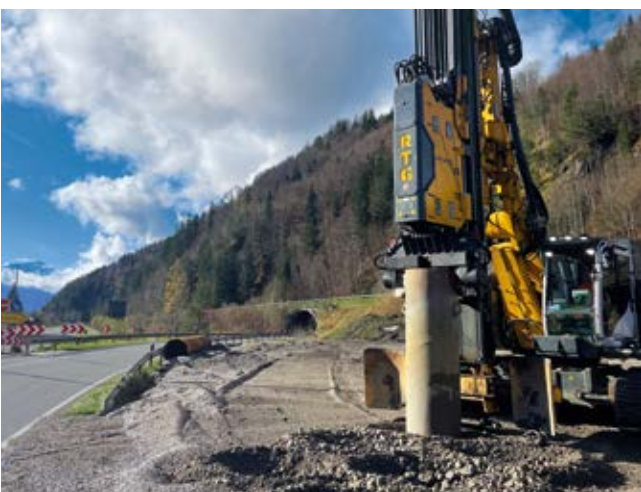
Neubau B2, Eschenlohe, Deutschland Für die neue Ortsumfahrung B2 wurden insgesamt 6.200 m Rütteltextilsäulen hergestellt.
