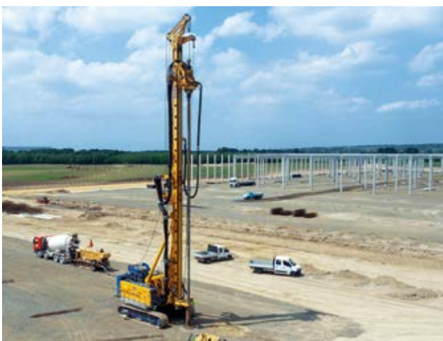
Neubau Logistikhallen, Maglód, Ungarn Herstellung von Gründungspfählen mit einem Durchmesser von 360 mm mittels FDP-Verfahren.
