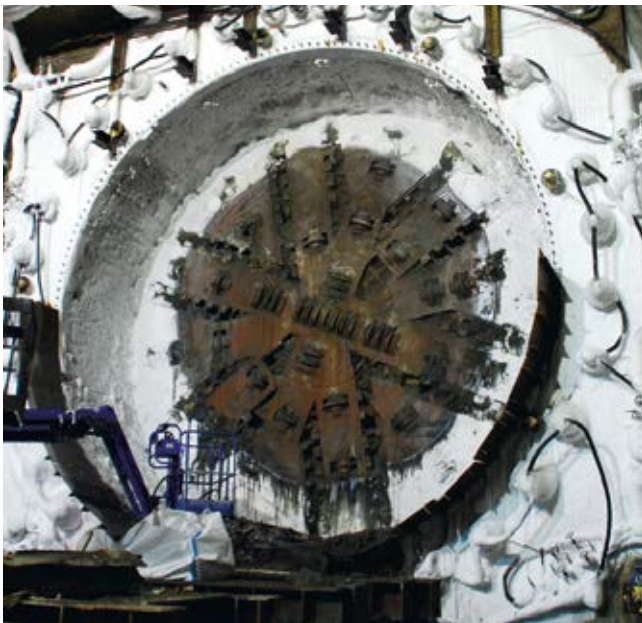
Üsküdar Metro Station, Istanbul, Türkei Herstellung von 33 horizontalen Gefrier- und zwölf Thermometerrohren durch Stickstoffvereisung.
