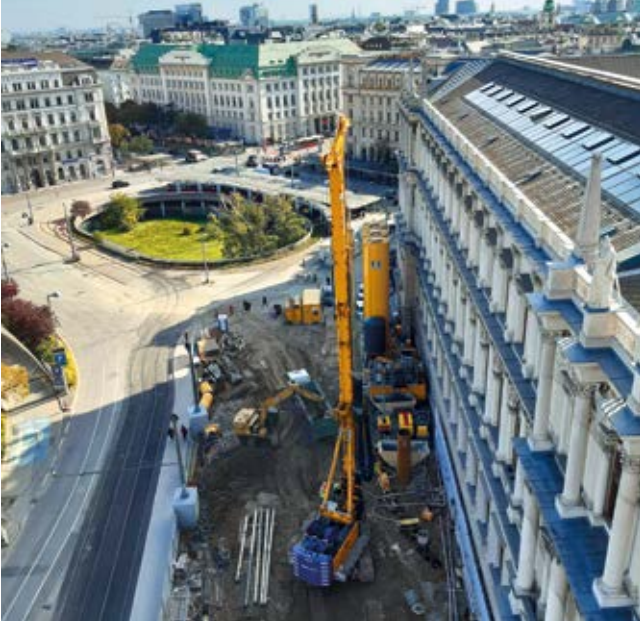
U-Bahn-Linienkreuz, Wien, Österreich Herstellung von ca. 35.000 m Bohrpfählen mit verschiedenen Durchmessern von bis zu 1.180 mm und Bohrtiefen von bis zu 61 m.
