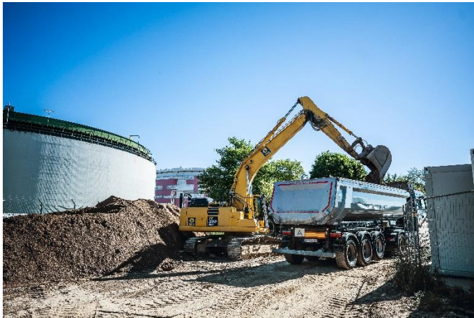
(2) Altlastensanierung und Entsorgung arbeiteten bei diesem Projekt Hand in Hand.
