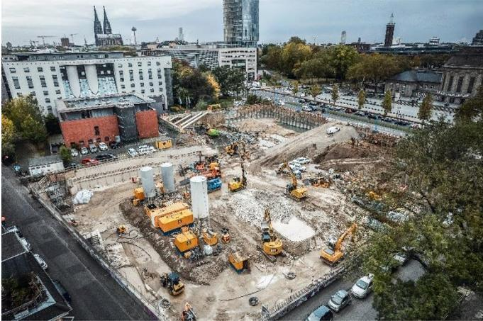
(1) Bauer Spezialtiefbau realisiert am Kölner Ottoplatz eine komplexe 8 m tiefe Baugrube für das neue LVR-Haus.
