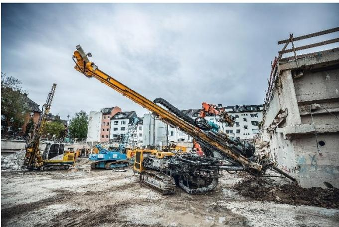
(2) Leistungsstarke Geräte von Bauer Maschinen, KLEMM (im Bild) und RTG sind für die Spezialtiefbauarbeiten im Einsatz.
