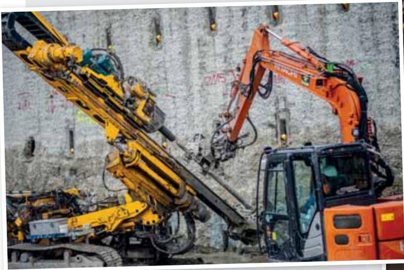
Mithilfe eines Baggers wurde das Innengestänge aus dem Bohrloch ausgebaut und in der Gestängebox abgelegt.
