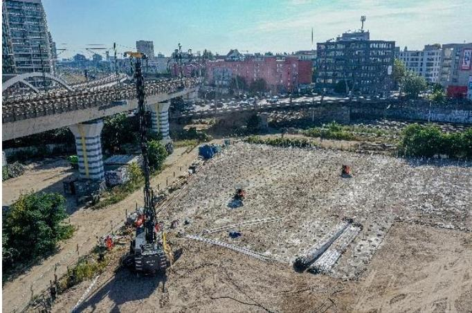
(3) Bauer Spezialtiefbau setzt eine Kombination aus Mixed-in-Place-Verfahren, Pfahlwänden und der eigens entwickelten LWS-Silikatgelsohle ein.
