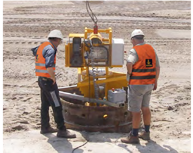
Seilneig beim Einsatz auf der Baustelle
