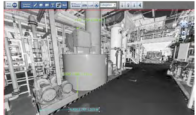
Aufmaß einer bestehenden Reinigungsanlage
