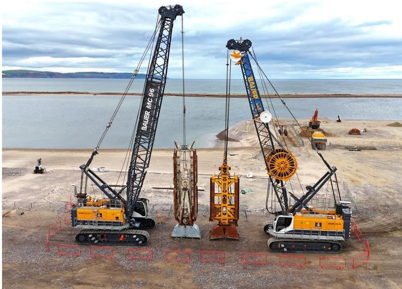
(1) Revitalisierung des Hafens im schottischen Ardersier: Bauer stellt mehrere Schlitzwände für die vordere Kaimauer und die hinteren Ankerwände her – und das in beeindruckenden Tiefen. © BAUER Gruppe
