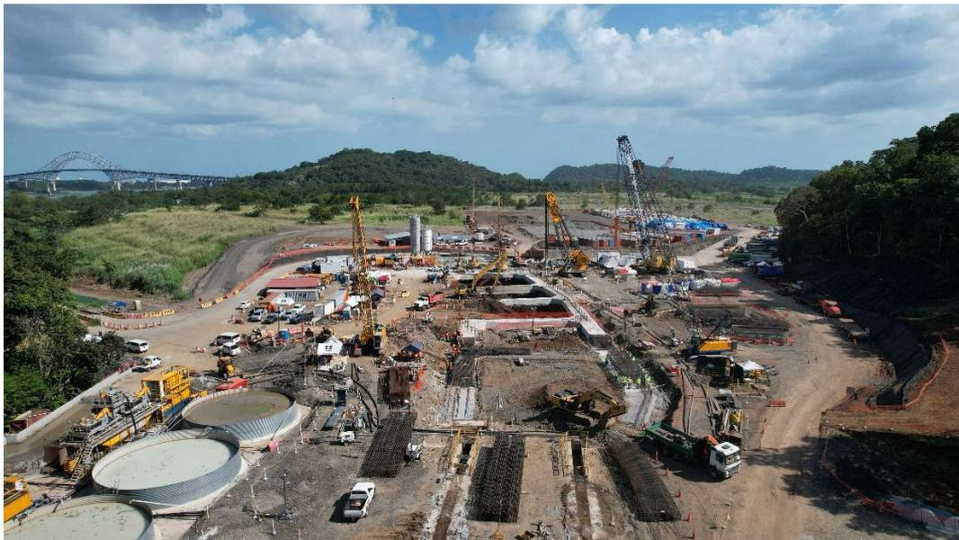
(1) Um einen Starterschacht für die Tunnelbohrmaschine herzustellen, führt Bauer Panama umfangreiche Schlitzwand- und HDI-Arbeiten aus.
