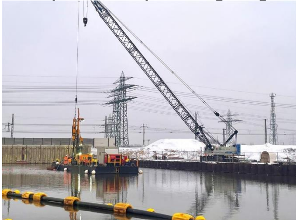
(1) Trogbaugrube West für späteren Tunnel unter dem Damm der Hafenbahn
