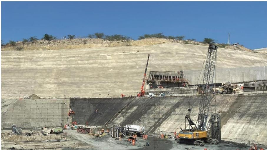
(2) Aufgrund der hohen Gesteinsfestigkeiten von 45 MPa waren in einigen Fällen Vorbohrungen notwendig.
