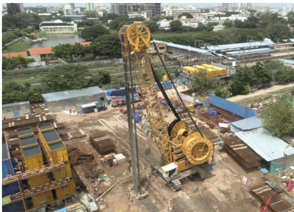
(2) BAUER MC 128 Seilbagger bei der Herstellung einer Schlitzwandlamelle
