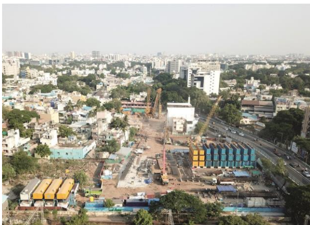
(1) Baustellenübersicht Chetpet Metro-Station in Chennai
