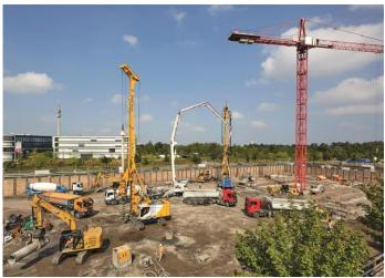
(1) Insgesamt wurden 301 Pfähle mit einem Durchmesser von 880 mm und bis zu 24 m Länge hergestellt.
