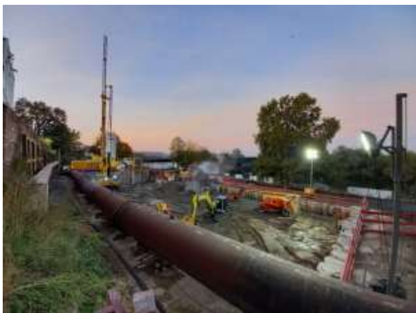
(3) Eine tiefliegende Hochdruckinjektionsdichtsohle dient der horizontalen Abdichtung.
